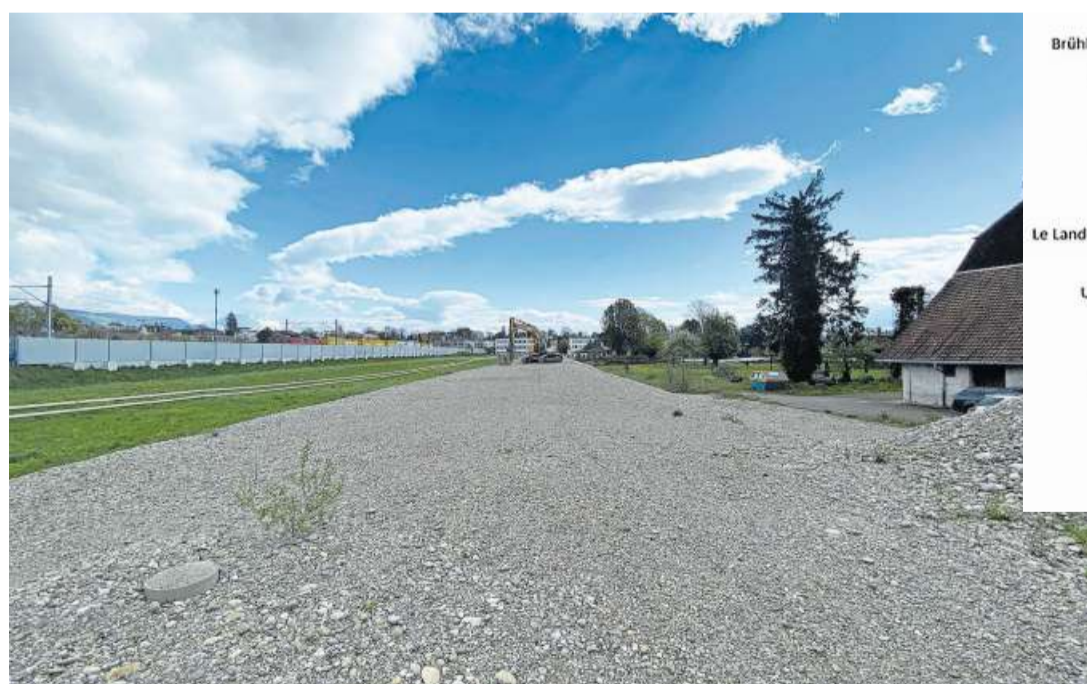
Der Schotter-Wall wird Vorbelastung genannt und verdichtet den Boden.
